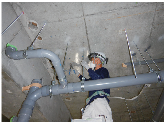
脚立の上で排水管の配管作業をするドック
